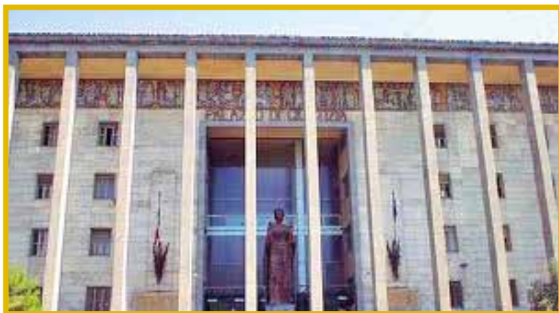
Catania - L'ingresso del Palazzo di Giustizia
