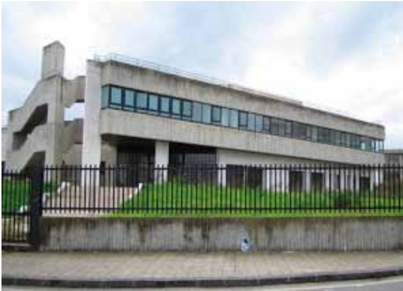
Giarre: La sede della locale Sezione del Tribunale, realizzata di recente dal Ministero della Giustizia
